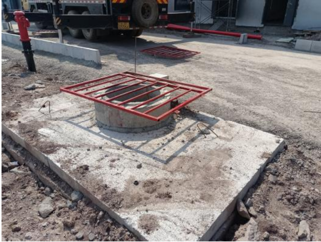
雨水管网施工
