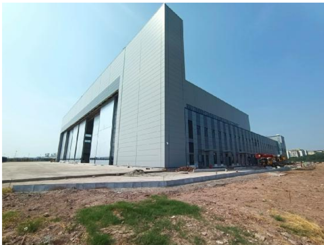
项目区施工照片
