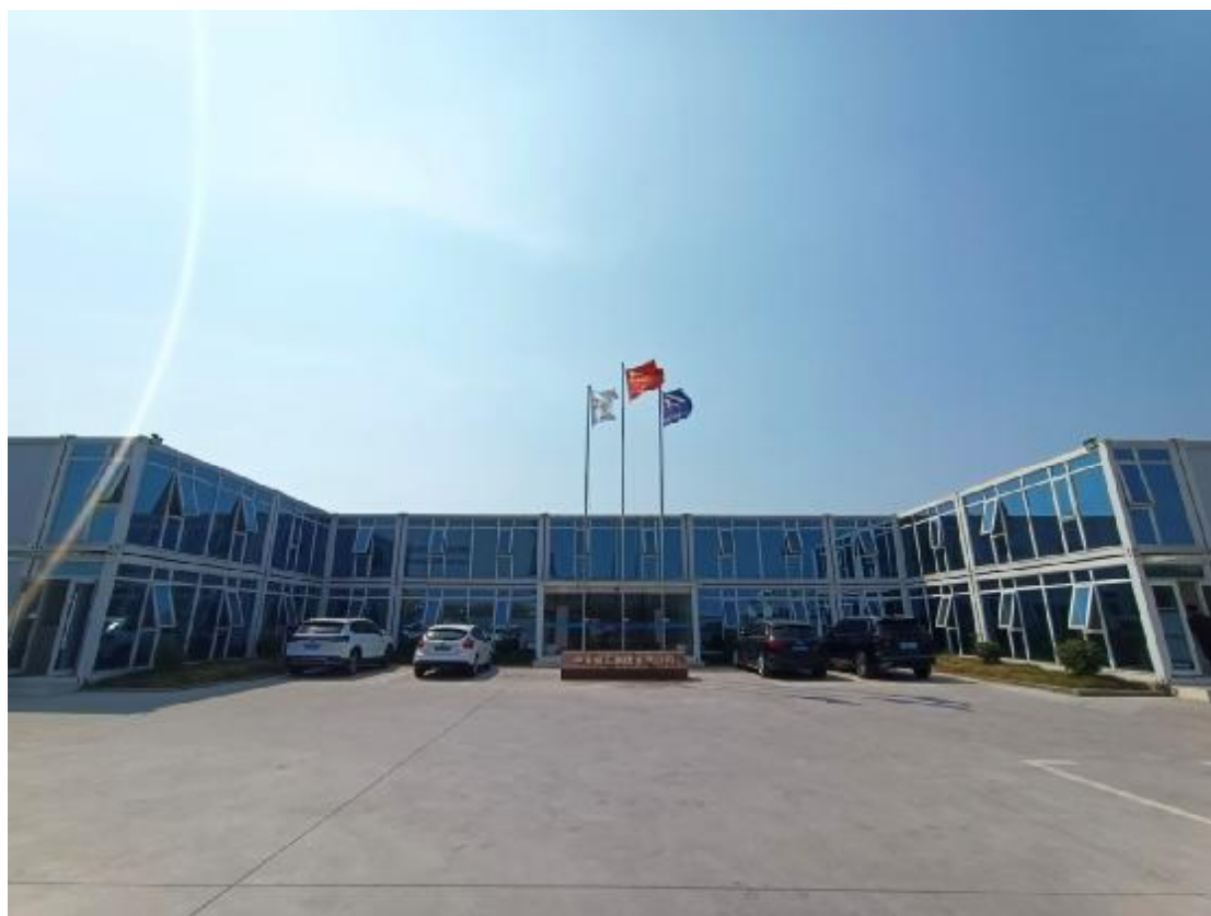
项目区施工照片
