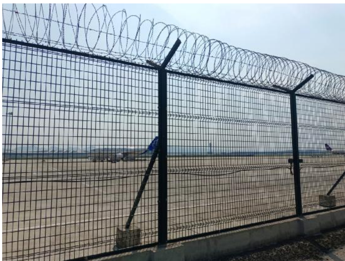
项目区施工照片
