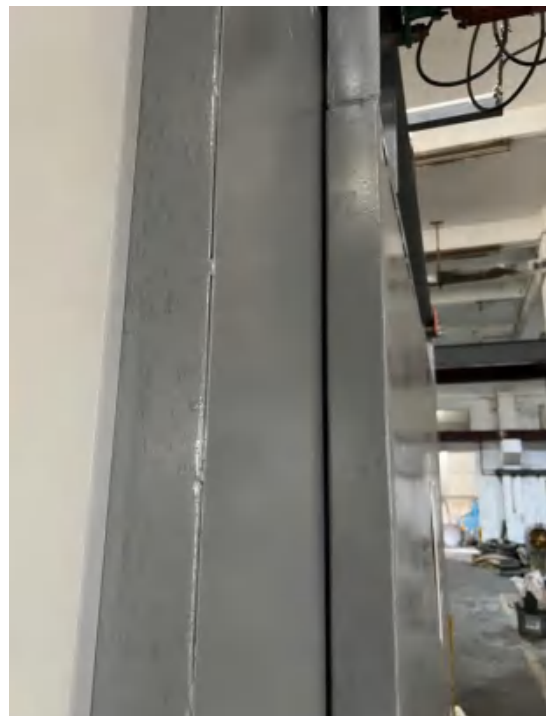
图 3-5 防护门搭接建设情况
