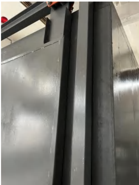
图 3-5 防护门搭接建设情况
