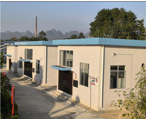
加药间+鼓风机房
