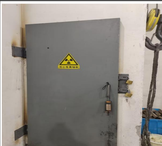
图 4-6 探伤室内放射源储源库双人双锁、电离辐射警示标志
