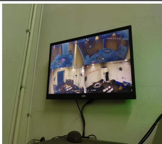
图 4-5 操作室内监控显示屏
