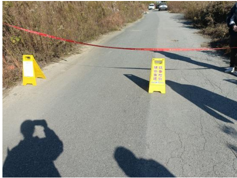
图 3-3 监督区警戒线及探伤作业公告
