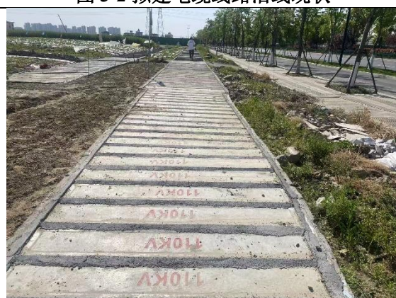
图 3-4 拟建电缆线路沿线现状
