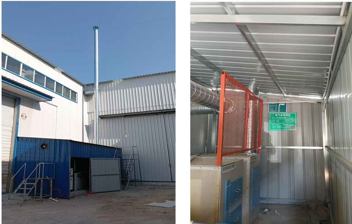
图4 板材开料废气排放口及监测平台 DA001
