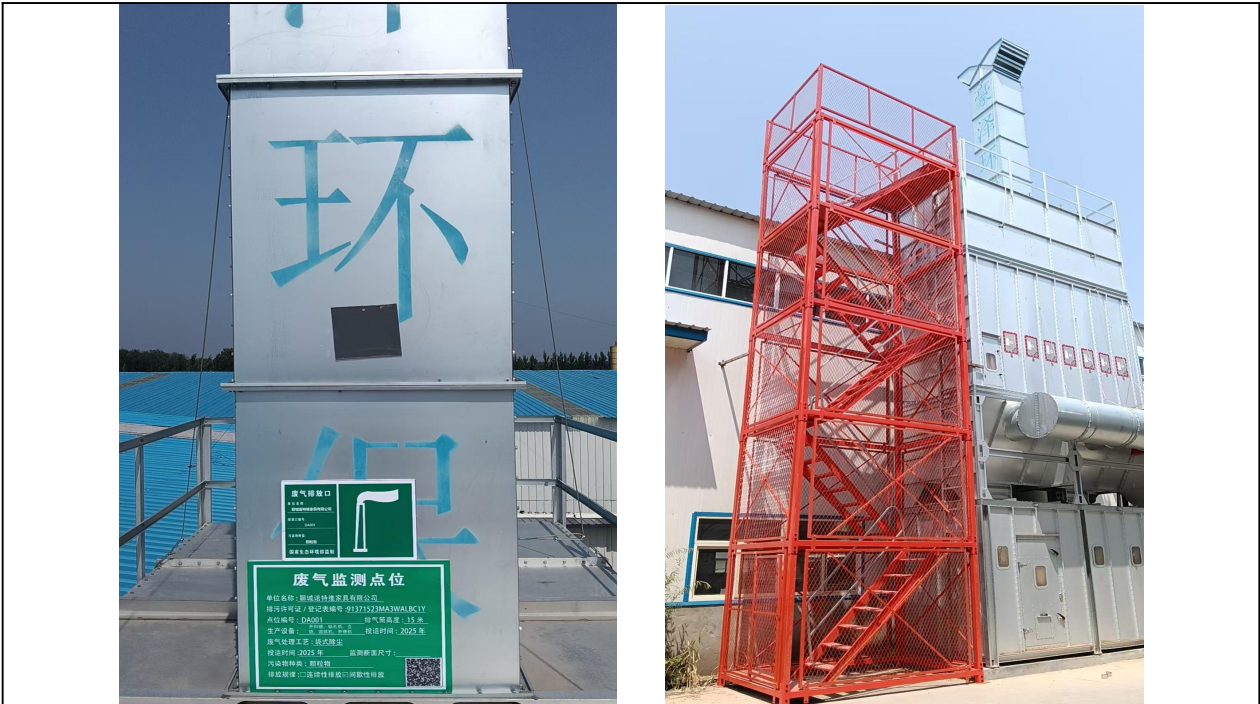
图4 板材开料废气排放口及监测平台 DA001
