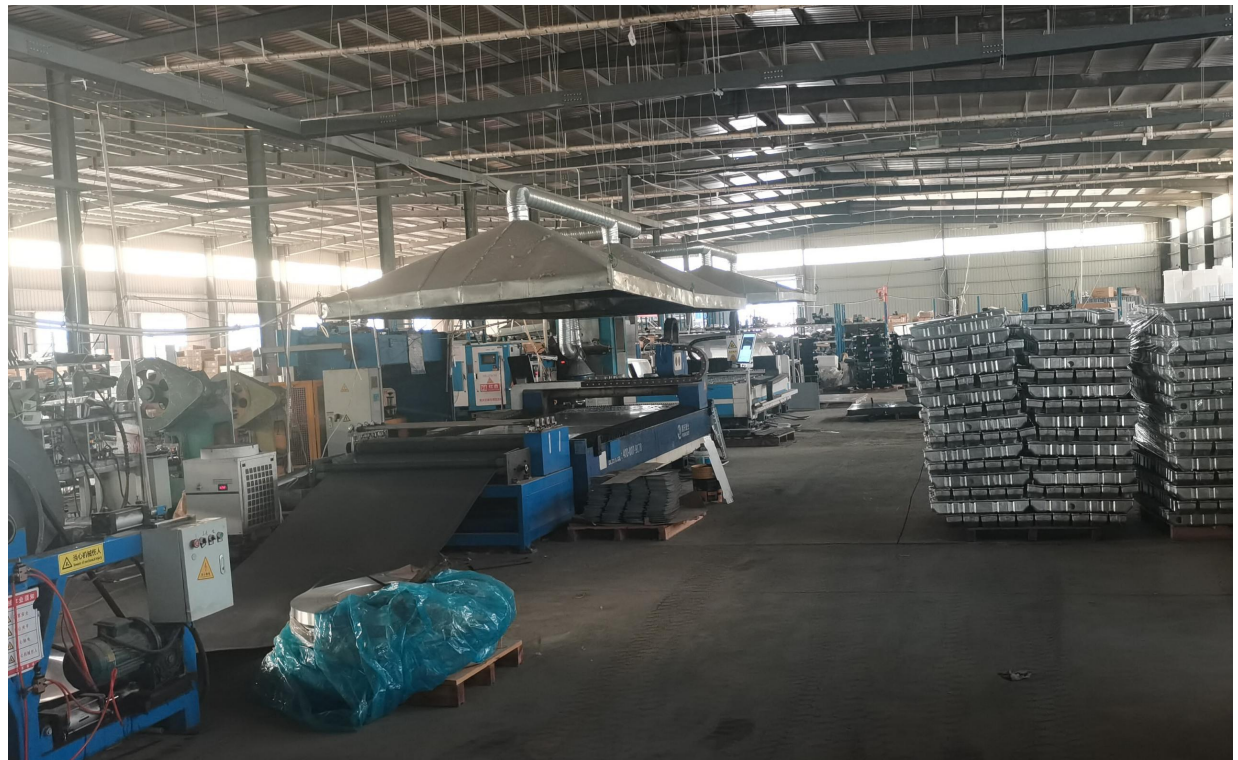
图8 焊接工序废气处理装置
